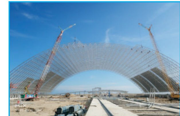
Kho dài nhà máy nhiệt điện Vĩnh Tân 4
